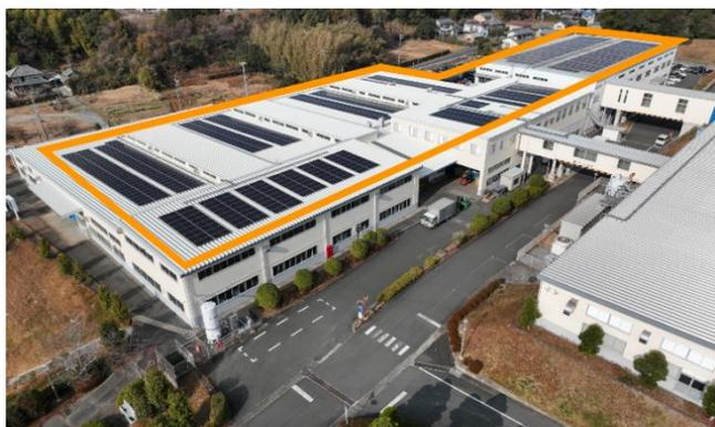
□で囲んだ部分が太陽光パネルを設置した屋根部分です。
